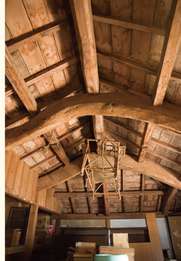
船の底をひっくり返したように見える小屋組
