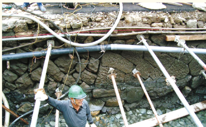
壁面が中央を境に左と右で石の組み方が違うのがわかる
